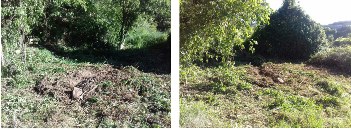
Figures 8 i 9 Vista exterior Fossa sèptica existent
