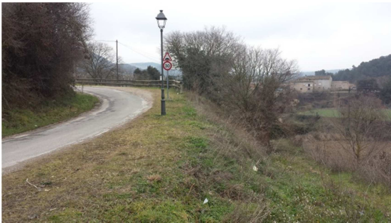
Figura 3 – Camí d'accés a la Depuradora
